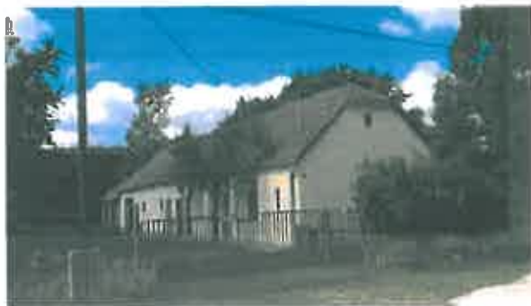
Kisbér - Tapolcáskepi Aranylátó Közösségi Központ épülete 2019
